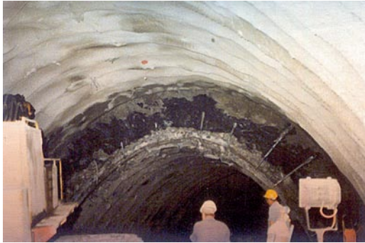
Fig. 2.7 Collapse of the cavity (S. Elia Tunnel)
