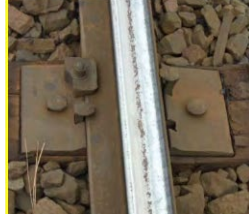
Mild Spalling
