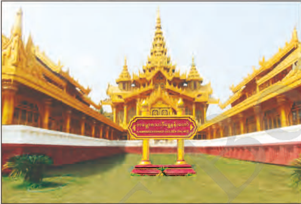
ပုံ-၁.၇ ဘုရင့်နောင်မင်းတရားကြီးလက်ထက် တည်ဆောက်ခဲ့သောပုံစံအတိုင်း ပြန်လည်တည်ဆောက်ထားသော ယနေ့ကမ္ဘောဇသာဒီရွှေနန်းတော်
