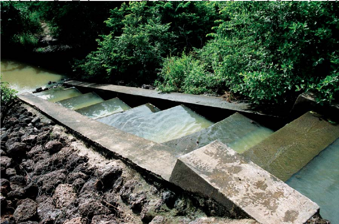
(ဘာကီနာ ဖာဆို)သည်၏ အထက်ဖက်နှင့် အောက်ဖက်သို့ ငါးများကူးသန်းနိုင်ရန် ဆောက်လုပ်ထားသော ငါးခုန်စင်။၎င်းသည် သဘာဝပတ်ဝန်းကျင်ထိန်းသိမ်းရေးအတွက် လိုအပ်သောရေစီးရေလာကောင်းမွန်ရေးအတွက် ဆောင်ရွက်ရာတွင် အရေးကြီးသော ရေအားအဆောက်အအုံဆိုင်ရာ တိုးတက်မှုတစ်ခုဖြစ်ပါသည်။
