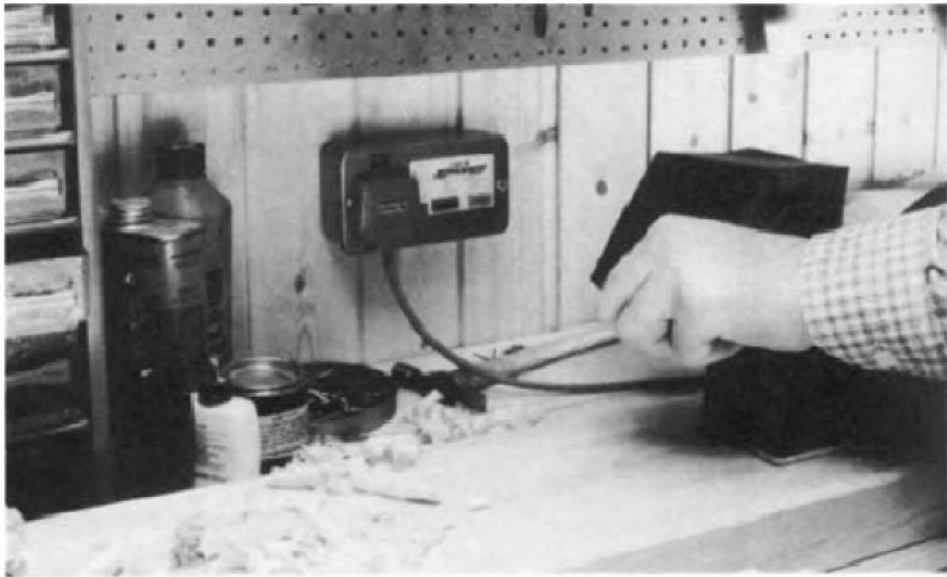
ပုံ ၅.၄ 13A socket outlet များအား 30mA residual current device နှင့်တွဲလျှက် ရရှိနိုင်ပါသည်။ ယင်းသည် IEE Regulations မှ RCD protect လုပ်ထားသည့် socket များလိုအပ်မှု နှင့် တစ်ခုသို့မဟုတ် နှစ်ခုမျှသော protected socket များသာလိုအပ်သော အခြေအနေများ စသည့် လိုအပ်ချက်များအား ပြေလည်စေနိုင်ပါသည်။ (Ashley and Rock Ltd)
