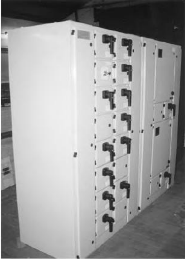
ပုံ ၄.၁၅ စီးပွားရေးလုပ်ငန်းများနှင့်သက်ဆိုင်သော နေရာများတွင်သုံးစွဲသော switchboard တစ်ခု။ ယင်း board တွင် outgoing switch ၁၂ခု ပါရှိသကဲ့သို့ main Air Circuit Breaker များလည်းပါရှိပါသည်။ (Pandelco Ltd)
