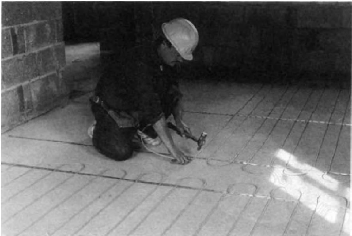
ပုံ ၆.၃ floor heating အတွက် cable များ install လုပ်နေပုံ (ESWA Ltd)
