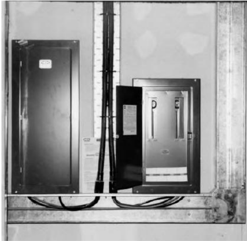
ပုံ ၄.၂၄ MCB distribution board များအားတပ်ဆင်နေစဉ်။ incoming cable သည် cable tray အပေါ်မှ သွယ်တန်းကာ outgoing cable များထည့်သွင်းရန်အတွက် trunking ကို တပ်ဆင်ထားပါသည်။ MCB များအားတပ်ဆင်မှု မပြုရသေးပါ။ (William Steward & Co. Ltd)
