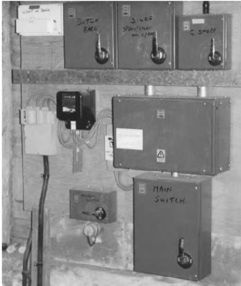
ပုံ ၆.၉ Agricultural installation တစ်ခုအတွက် main switch။ Dutch barn, silos နှင့် grain store တို့သို့ fuse switch တစ်ခုစီဖြင့် လျှပ်စစ်ဓါတ်အားကိုပေးပို့ပါသည်။ မှတ်သားရန်မှာ installation သည် three phase ဖြစ်ကာ residual current circuit breaker ဖြင့် protect လုပ်ထားပါသည်။ (William Steward & Co Ltd)
