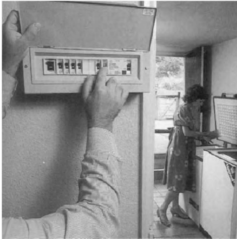
ပုံ ၄.၉ circuit breaker များနှင့် main residual current circuit breaker တို့ပါဝင်သော consumer unit တစ်ခု (MK Ltd)
