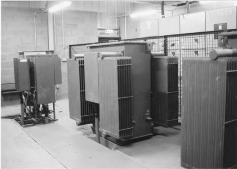
ပုံ ၄.၁ factory တစ်ခု၏ sub-station။ Incoming အား 11kV ring main မှ ရယူကာ 800kVA, 11kV မှ 415V transformer များသို့ လျှပ်စစ်ဓါတ်အားပေးပို့သည်။ sub-station အတွင်းရှိ distribution board သည် 4pole 1600A Air Circuit Breaker များ (ACBs) အား 1200A တွင် set လုပ်ထားကာ 2000A rated ရှိသော 4pole bus coupler တစ်ခုတို့ ပါရှိပါသည်။ (W.T. Parker Ltd)
