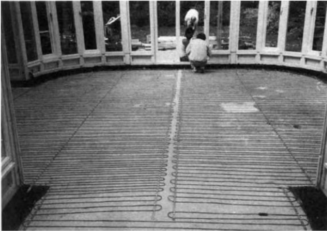
ပုံ ၆.၄ St Johns Wood ရှိ Orangery တွင် floor warming တပ်ဆင်ခြင်းလုပ်ငန်းပြုလုပ်နေပုံ (DE-VI Electroheat Ltd)
