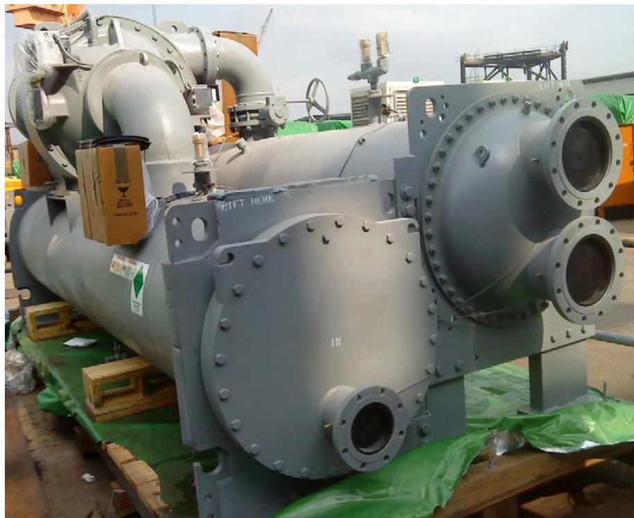
Fig. 2.8. Carier centrifugal chiller
