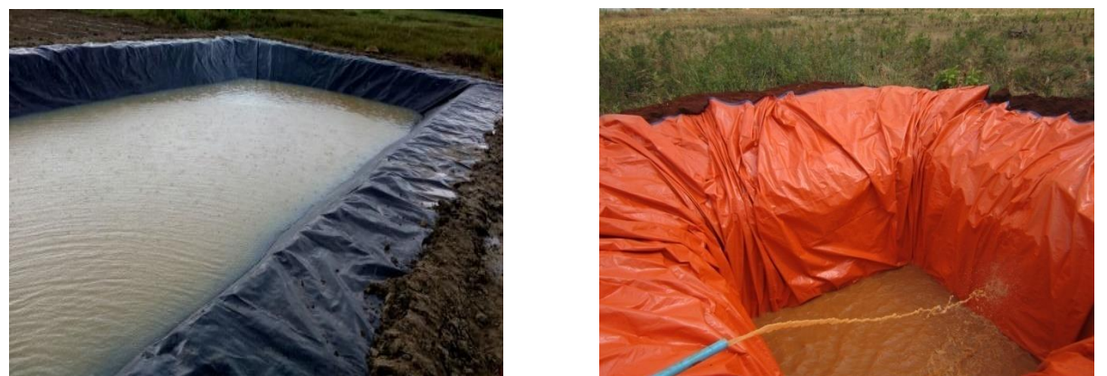
ပုံ ၂.၃၄ YAU ရှိ ၅၀၀ ဗီနိုင်းစဖုံးအုပ်ထားသော ရေကန်ငယ် (ဝဲ) ၊ ပြင်ဦးလွင်ကော်ဖီခြံတွင် တွေ့ရှိရသော ရေကန်ငယ်တစ်ခု (ယာ) (© Myint Thaung)
