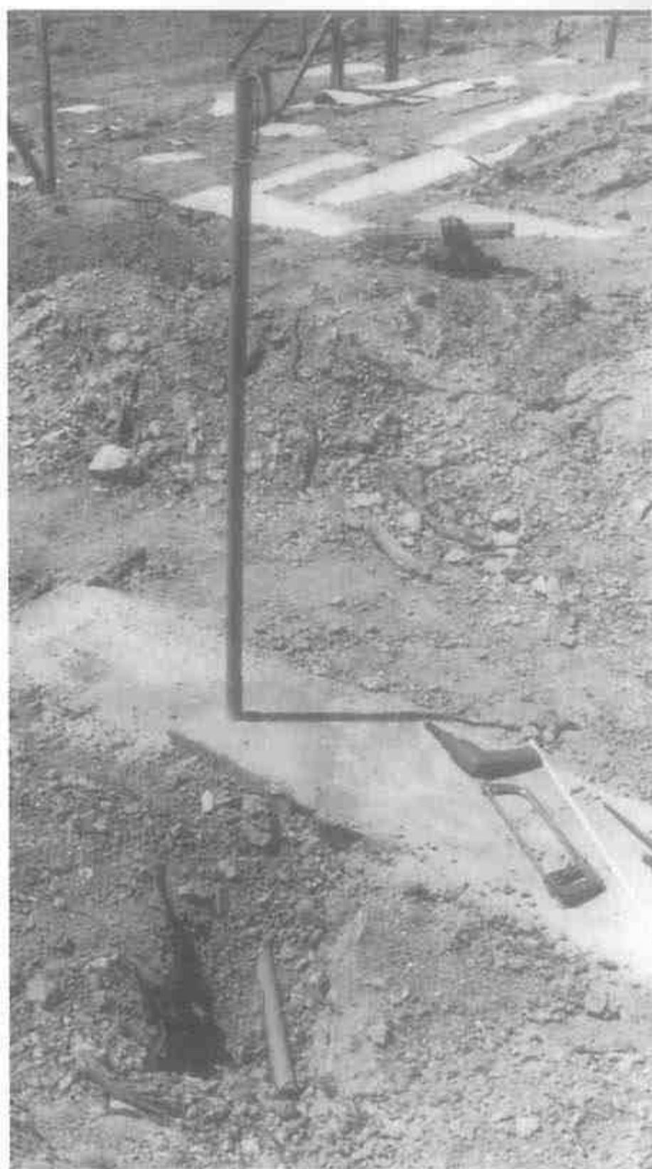
Fig. 7.23(b) Conduit for a consumer's underground mains, placed before concrete pour
